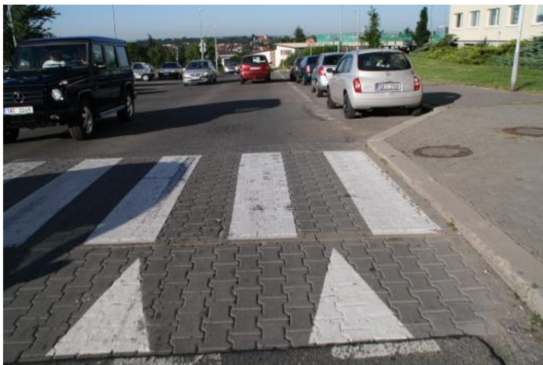
20 – ulice K Verneráku – před Volhou (KRITICKÉ MÍSTO 5) – lokální zklidnění fyzickými stavebními prahy není žádoucí překážkou pro tranzitní (průjezdnu) dopravu Kunraticemi mezi Jižním městem a Libuší
